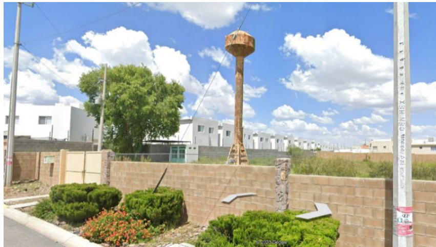
Imagen 47. Tanque elevado Fracc. Andalucía.
