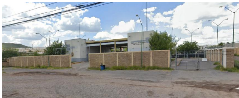
Imagen 94. Estación de Bomberos No. 7
