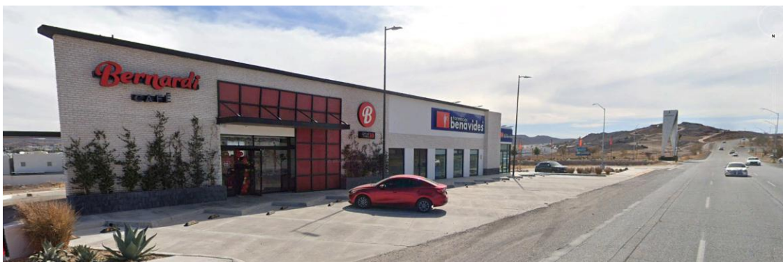
Imagen 19. Locales comerciales fuera del Fracc. Ankara sobre la Av. Teófilo Borunda Ortiz. Fuente: Google Earth, captura octubre 2025.
